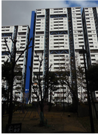
写真 8：阪神淡路大震災時の 破綻箇所 (2層目の辺り)
