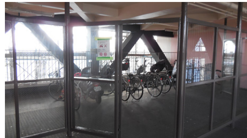
写真 12：共用階の共用エリアの使用状況
