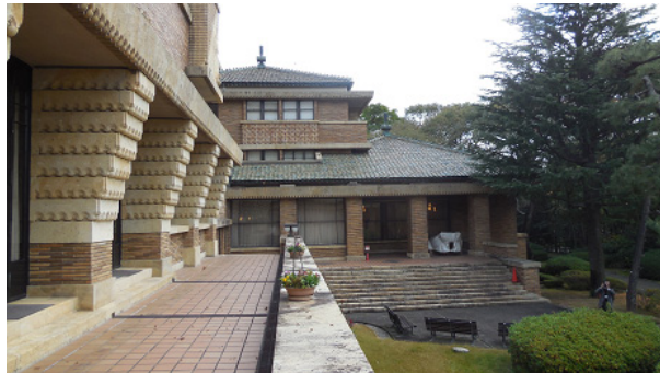
写真3：庭園から見た甲子園会館の柱の状況
